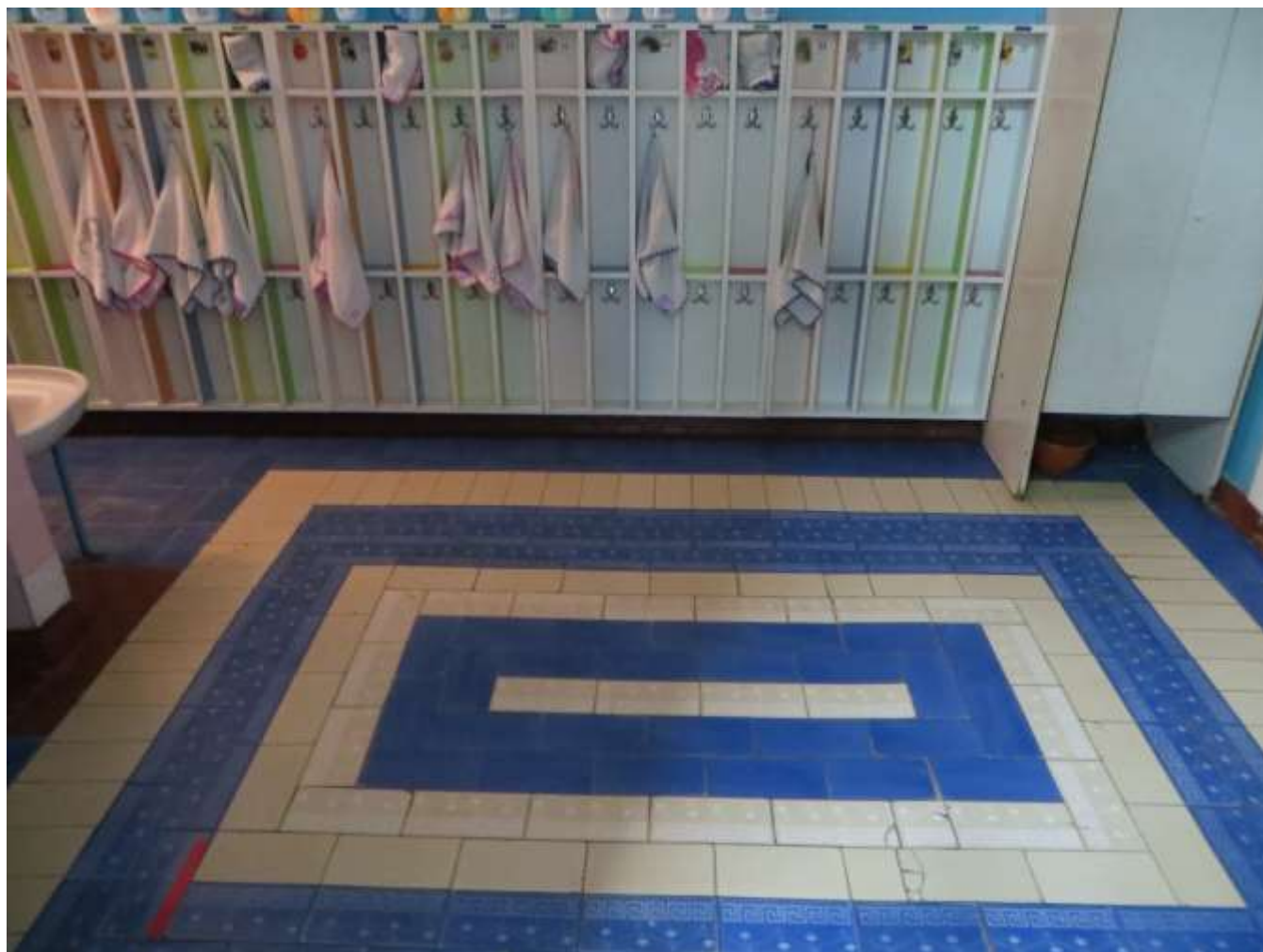
Figură 13 Pardoseala tip Pn3 la un punct sanitar din grupele de copii
