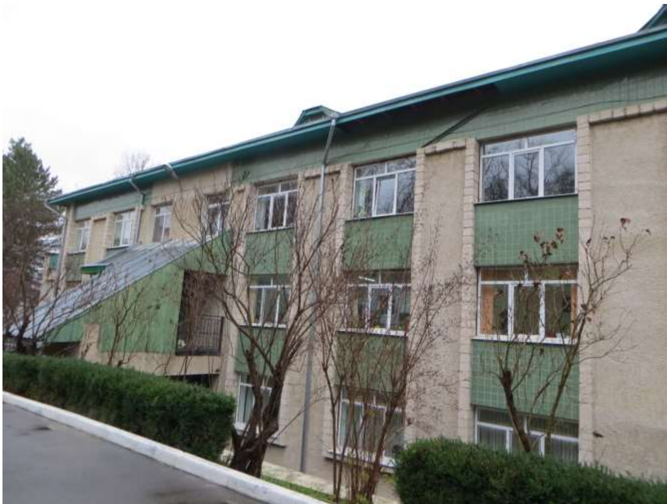
Figură 8 Acoperișul tip șarpant din partea de WEST (P2) a clădirii
