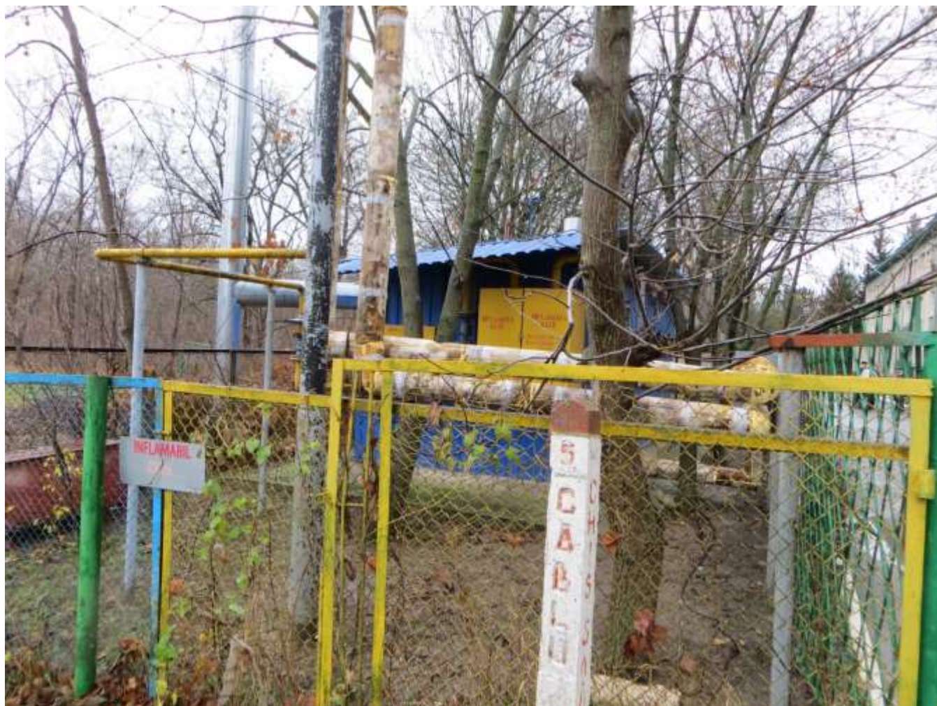
Figură 25 Punctul de ajustare a presiunii gazului natural
