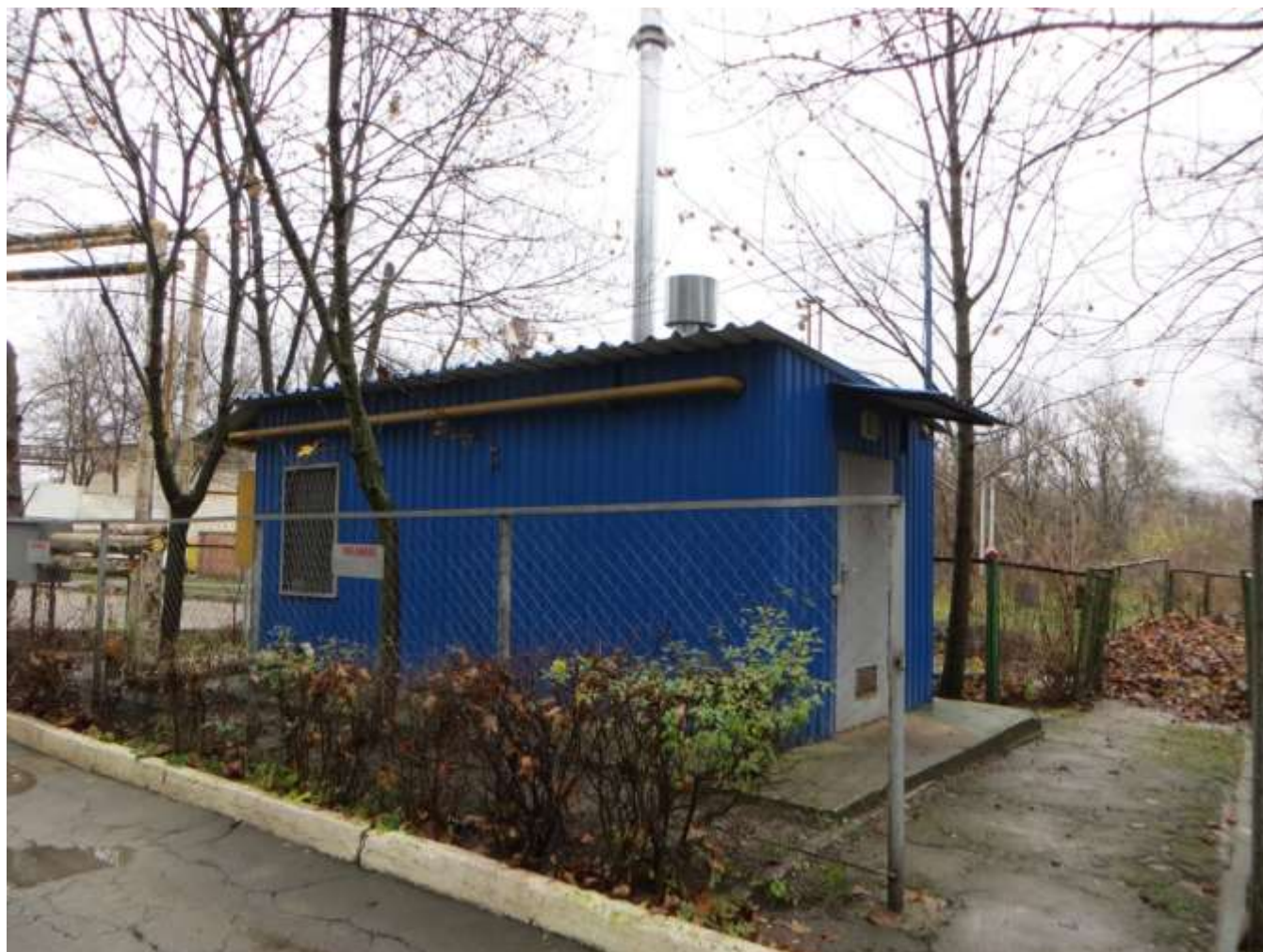
Figură 17 Aspectul exterior al cazangeriei autonome a grădiniței
