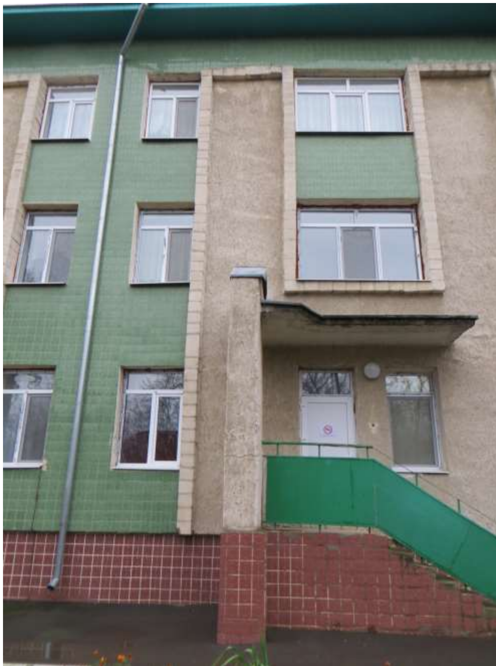
Figură 15 Ferestrele și usa de la peretele cu codul P4 a clădirii Grădiniței
